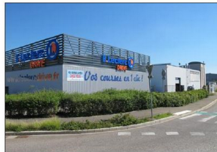
Le Leclerc Drive de Saint-Louis disposera bientôt de locaux de stockage beaucoup plus grands, situés dans les anciens locaux de l'imprimerie de Saint-Louis. Photo L'Alsace/S.Sp.
