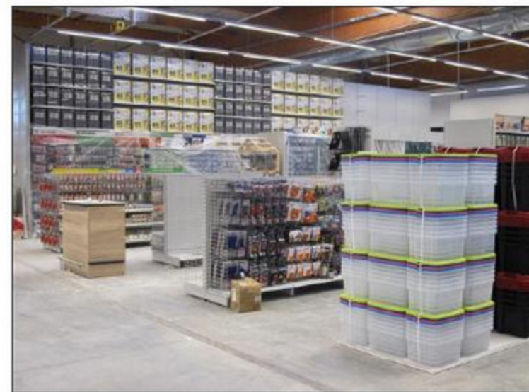
Les travaux sont toujours en cours au Brico Leclerc de Saint-Louis, qui s'étendra sur près de 10 000 m 2 et doit ouvrir lors du dernier trimestre 2020, mais certains articles sont déjà en rayon. Photo L'Alsace/S.Sp.
