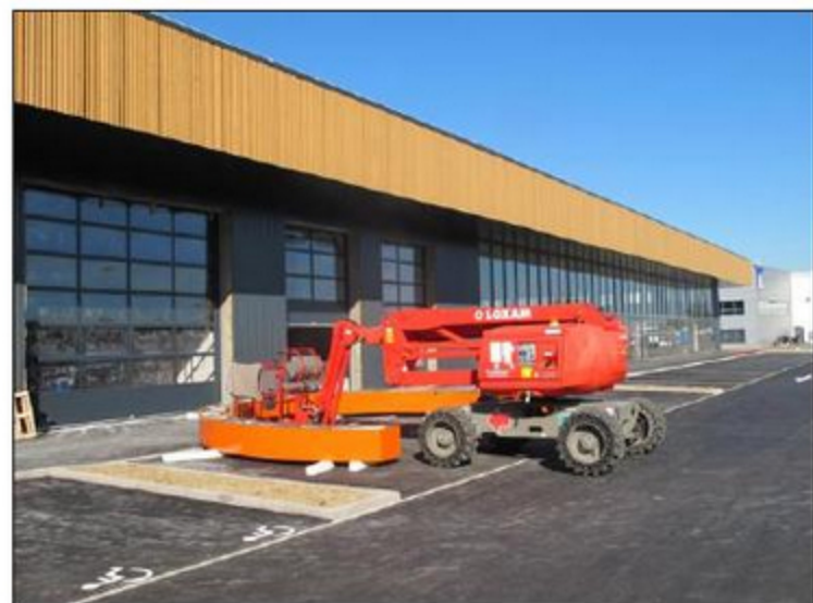
Les travaux vont bon train au centre auto Leclerc de Blotzheim, qui devrait ouvrir le 21 octobre. Photo L'Alsace/S.Sp.
